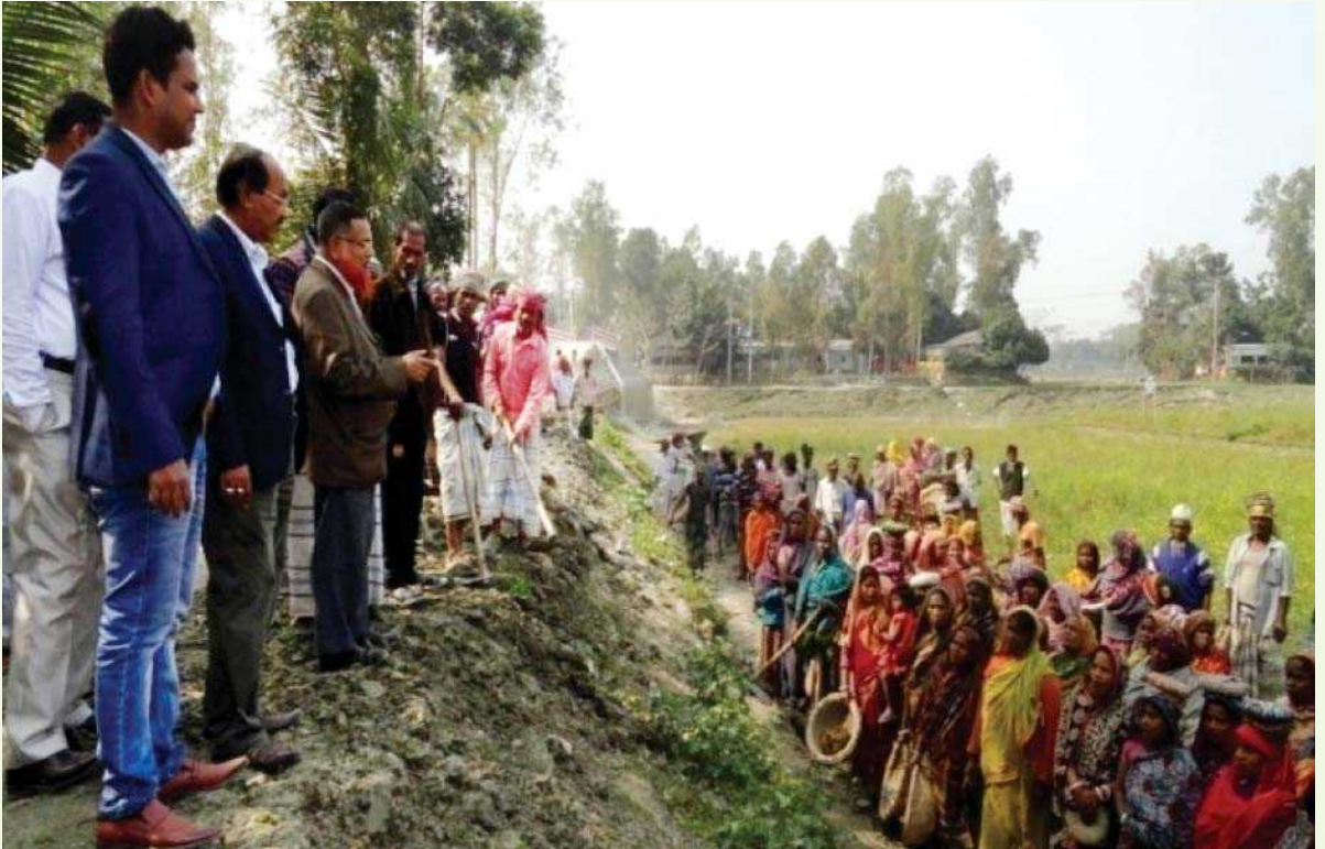
দুর্যোগ ব্যবস্থাপনা অধিদপ্তরের পরিচালক (মুওপ) জনাব মোহাম্মদ আনিছুর রহমান কর্তৃক সিরাজগঞ্জ সদর উপজেলার ইজিপিপি প্রকল্পের রাস্তার কাজ পরিদর্শন করছেন।
