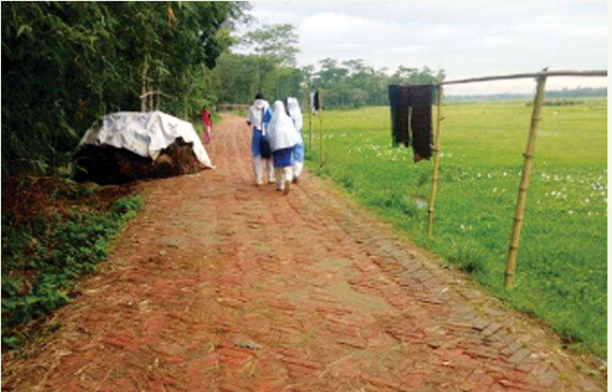
সিলেট জেলার দঃ সুরমা উপজেলার (ক) সিলেট ফেঞ্চুগঞ্জ রোডের কোনাচর - তিরাশী গ্রামের রাস্তা পর্যন্ত (১০০০ মি.) রাস্তায় এইচবিবি করণ
